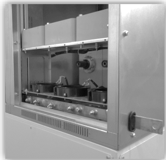
Rys. 6-6. UZIEMIENIE SCELL-MONO
