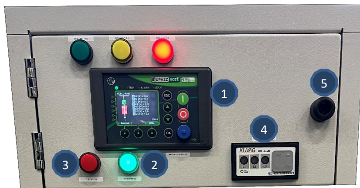
RYS. 3-7. STANDARDOWY PRZEDZIAŁ NISKIEGO NAPIĘCIA (250 MM)
