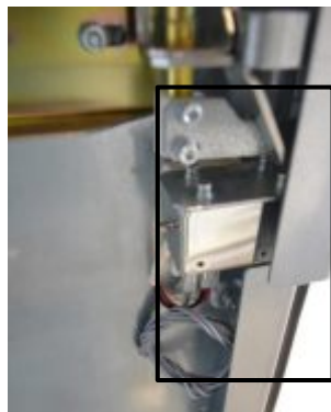
Blokada elektromagnetyczna uziemnika
