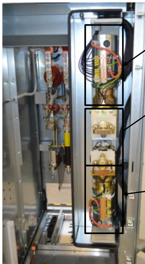
Pole z rozłącznikiem obciążeniowym z bezpiecznikami z napędem silnikowym
