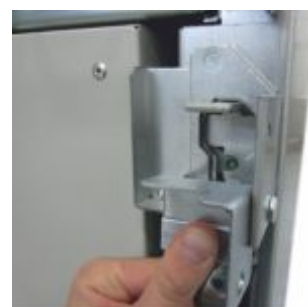
Gniazdo przestawiania uziemnika
